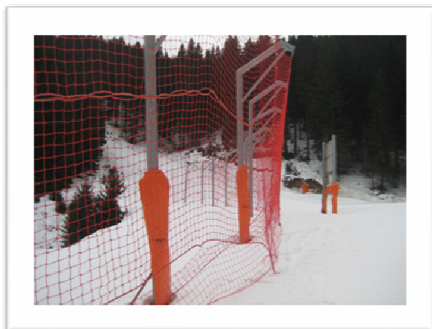
Слика 20. Стубови, струњаче и заштитна мрежа (Подножје жичаре Црна Дубока)
