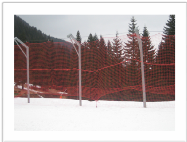
Слика 19. Заштитна мрежа
