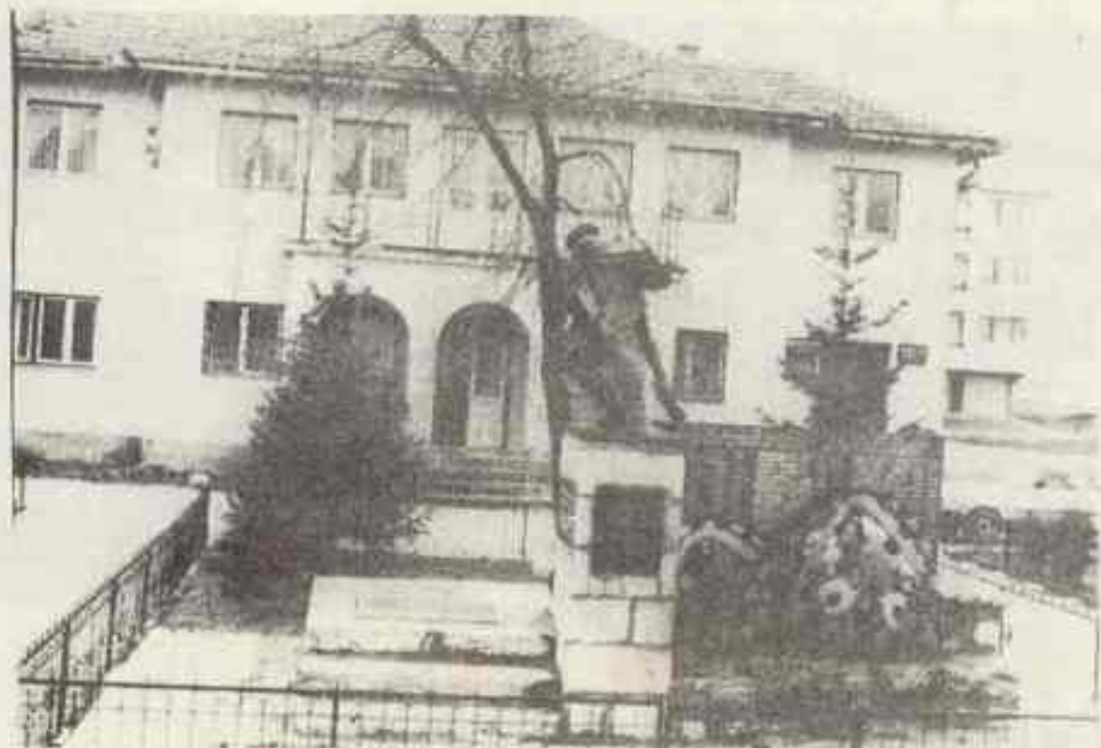
Zgrada u kojoj se nalaze prostorije »Romanije«
